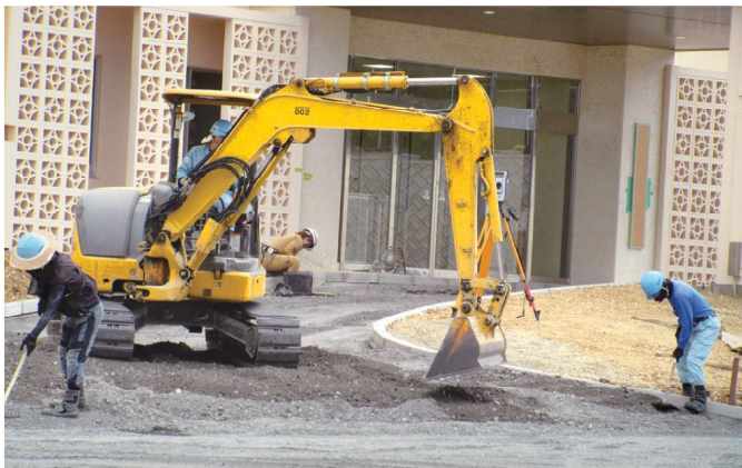
新庁舎周辺の土木工事がまだ続けられている(2月28日)
