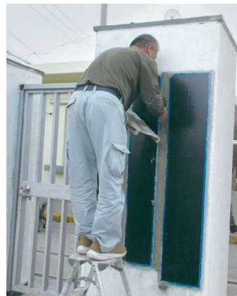
ゲートで新しい看板の取付をする作業員(2月28日)
